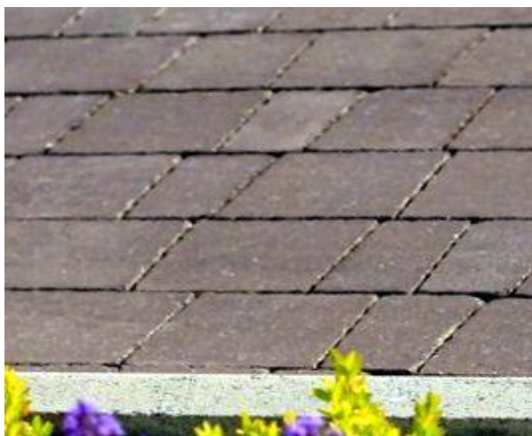
kostki betonowewibroprasowane, bezfazowe, granitopodobne grub. 8,0 cm
